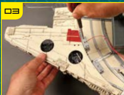
Совместите отверстия в «жвале» с отверстиями в опорных пластинах каркаса. Начните «наживлять» винты.
